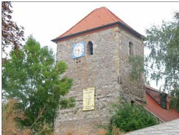
Das Zifferblatt wurde in einer der beiden Schallöffnungen des Turmes im 3. Obergeschoss eingebaut.
