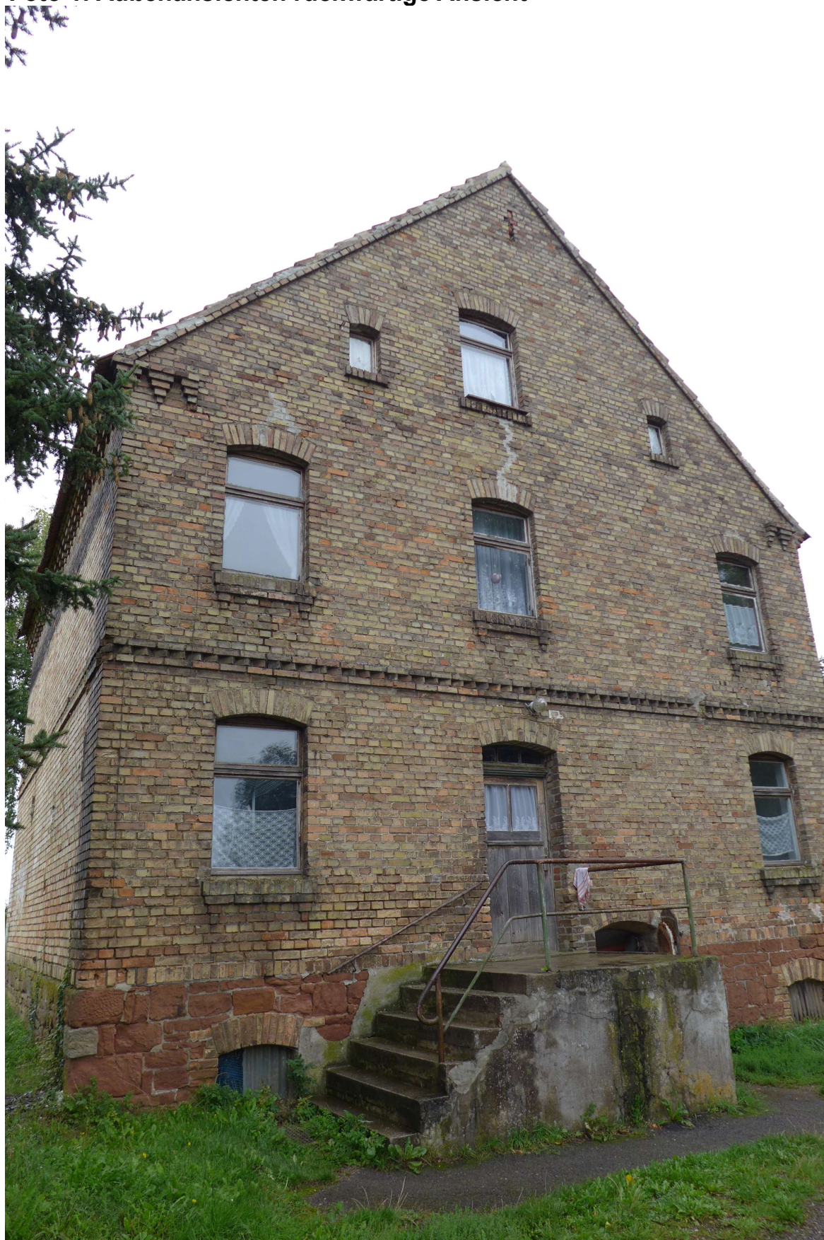
Foto 1: Außenansichten rückwärtige Ansicht
